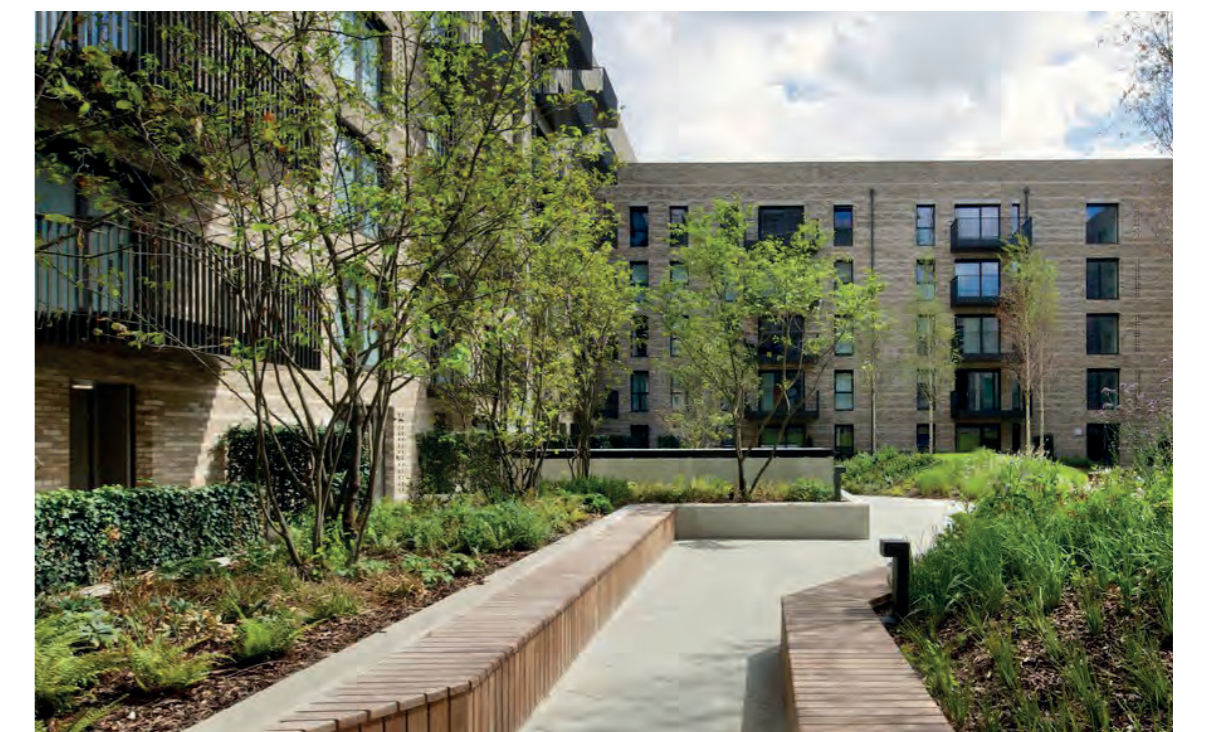
Gebouwen die in verschillende richtingen staan, maken compacte en duidelijke buitenruimtes waar bewoners zich meer verantwoordelijk voor voelen.
